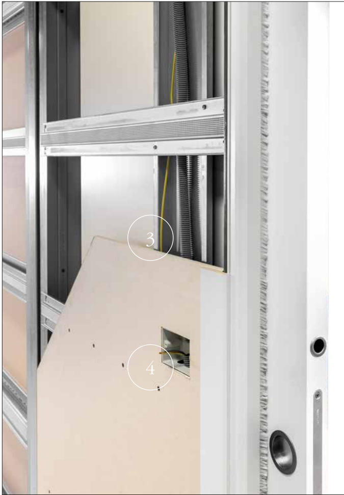
Telaio ECLISSE Luce - versione cartongesso
